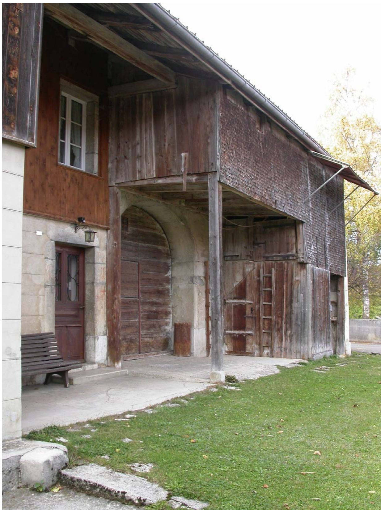
L'arrière de la maison, soit façade au levant !
